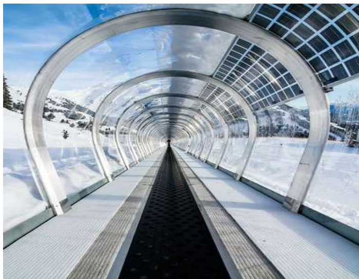
TUNNEL POLIFUNZIONALE DOTATO DI PANNELLI SOLARI
