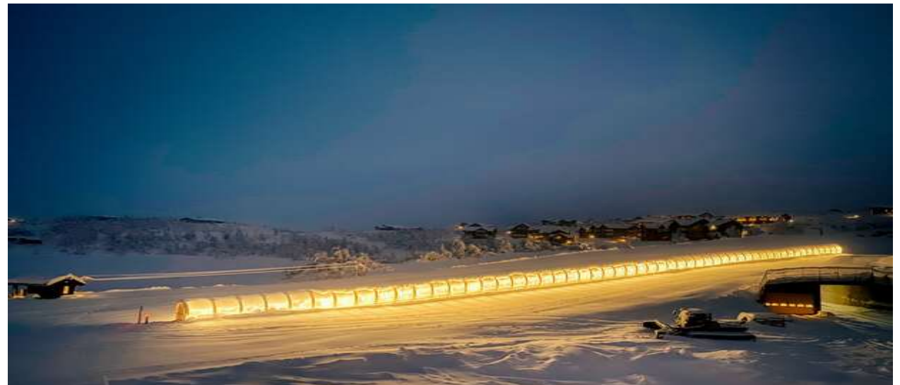
VISIONE NOTTURNA TUNNEL POLIFUNZIONALE ALIMENTATO AUTONOMAMENTE CON ENERGIA SOLARE
